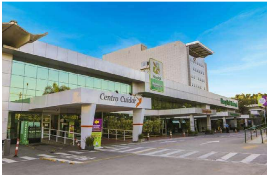
Fachada do Hospital Unimed de Volta Redonda, no município de mesmo nome, no Rio de Janeiro
